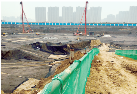
深基坑内覆盖有防尘网
