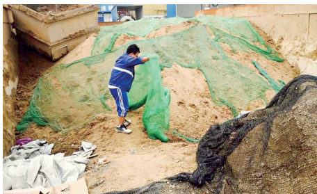
工地裸露区域盖上防尘网
