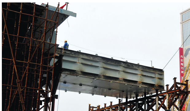
正在施工中的农业路跨花园路钢箱梁
