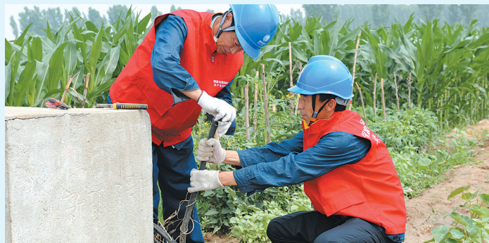
党员服务队检修灌溉设备
