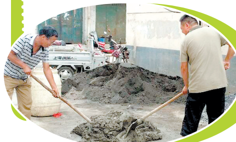
发改委工作人员正在进行路面整修
