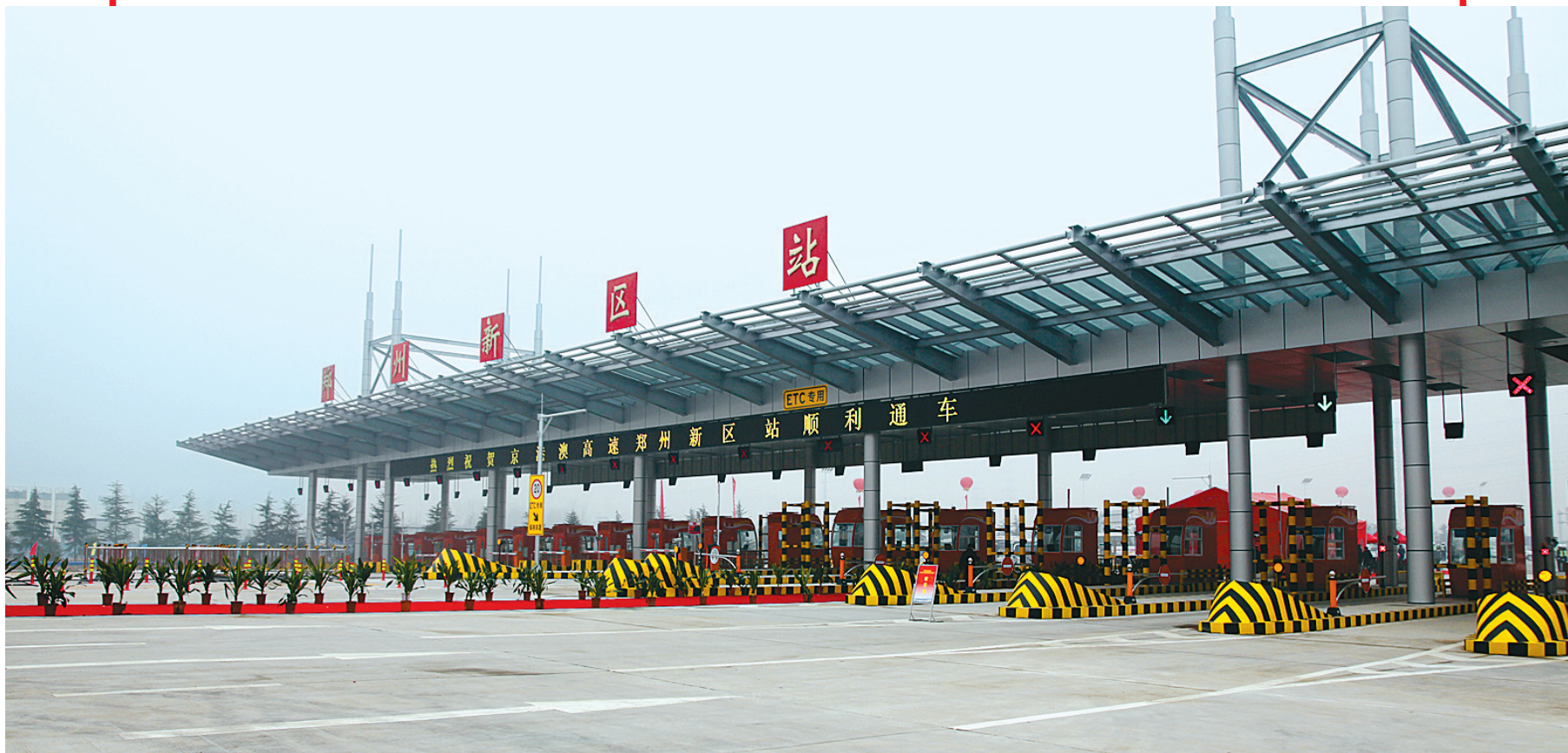
新建高速出入口, 出行更便捷。 郑州报业集团全媒体记者 丁友明 通讯员 梁明 图
