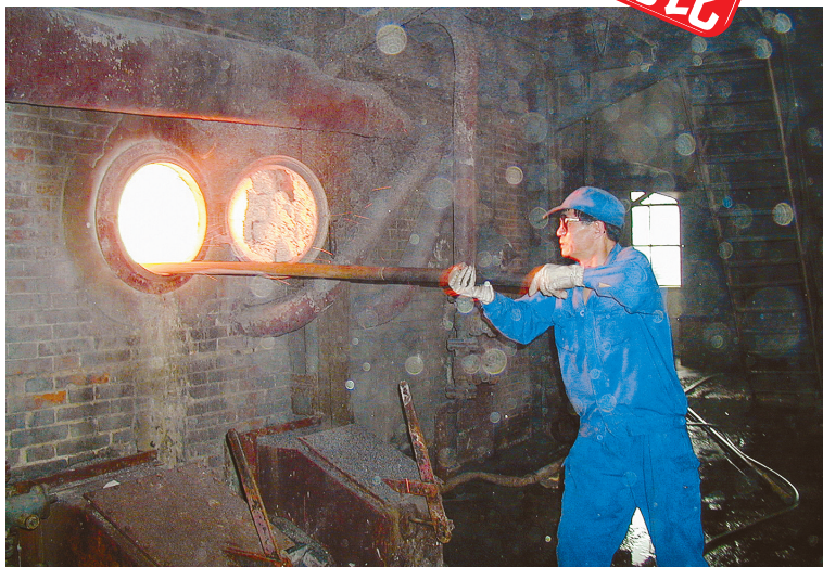
煤改气前,司炉工作人员观察锅炉燃烧情况 郑州报业集团记者 聂春洁
