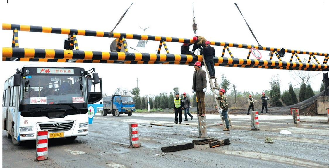
为维护道路安全，近日，荥阳市城市管理执法局组织人员拆除塔山南路损坏限高杆上部，利用现有限高杆设施的地基，加固设置限高杆一套。同时还配合公安部门安装监控设备，以监控人为损坏限高杆的行为，有效阻止超限运输及沿途遗撒。 荥阳播报 王世端 通讯员 王爽 李参 文/图
