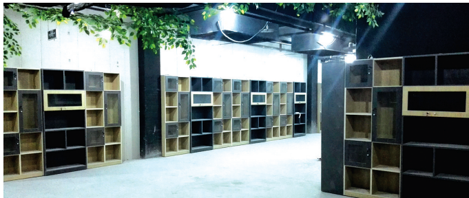
区域加紧施工中 教育广场室内公共
