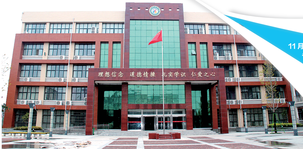
商都路小学办公大楼
