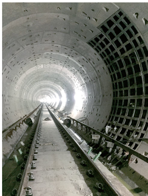
2号线一期工程隧道全线“洞通”
