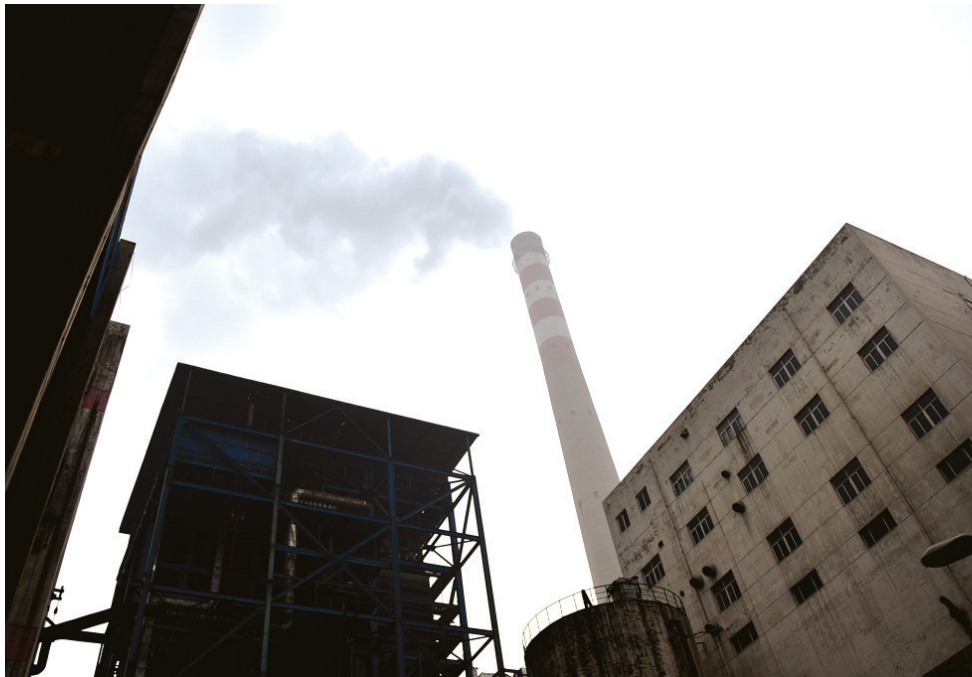
新力电力公司“煤改气”后,烟囱冒白烟
