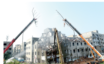
拆干工地,一边洒水降尘,一边施工
