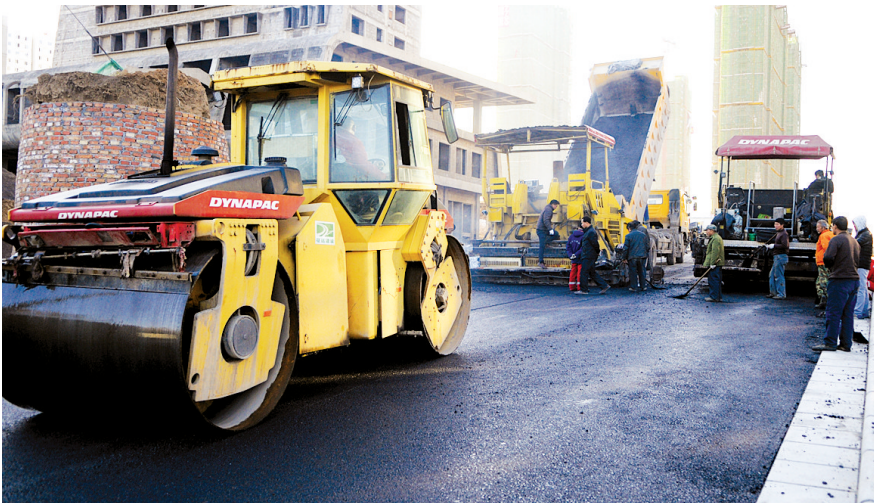
施工中的葛蒲路
