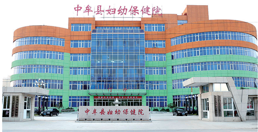
中牟县妇幼保健院新址
