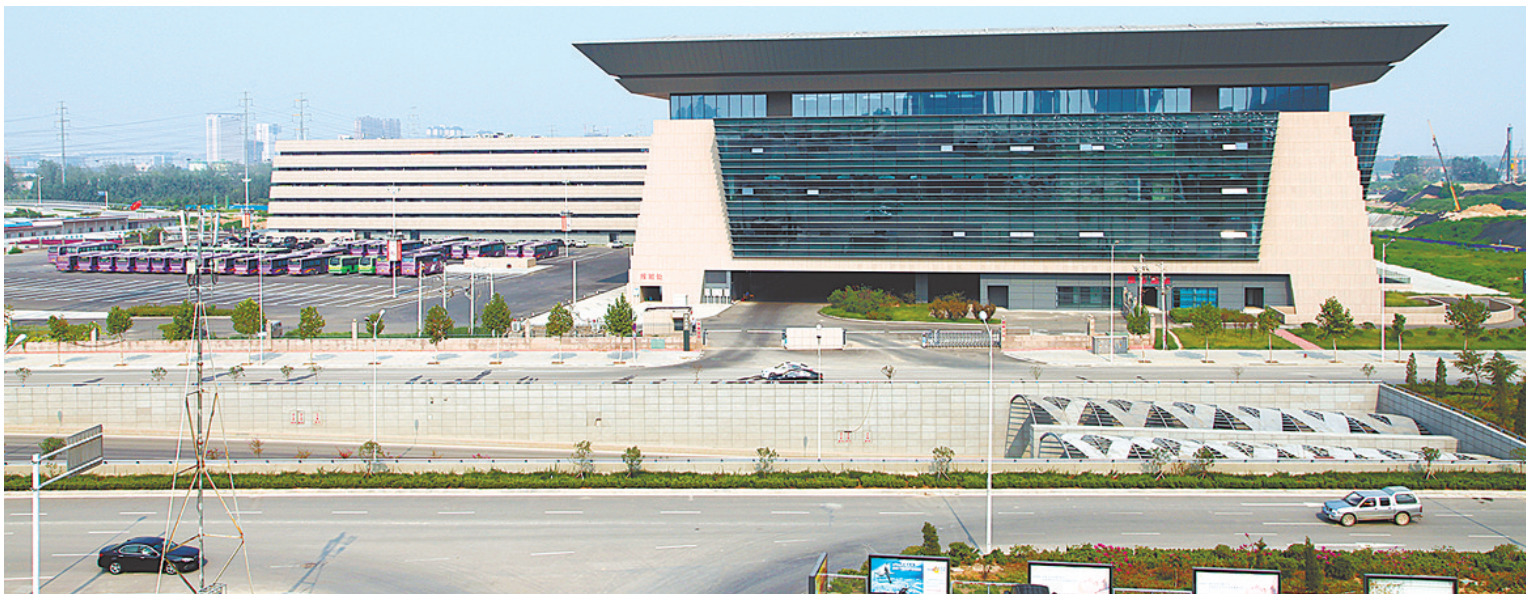
由郑州交通建设投资有限公司融资建设的郑州综合交通枢纽公路客运站
