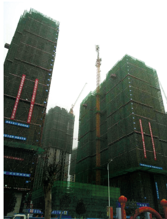
五龙口村安置房一期项目顺挂封顶
