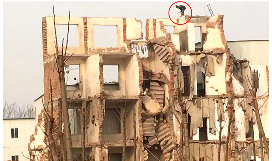
图中圆圈处是正在作业的工人
