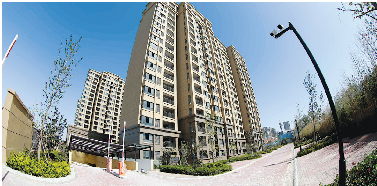
毛庄村征迁村民安置区一期工程完工,村民乔迁新居指日可待
