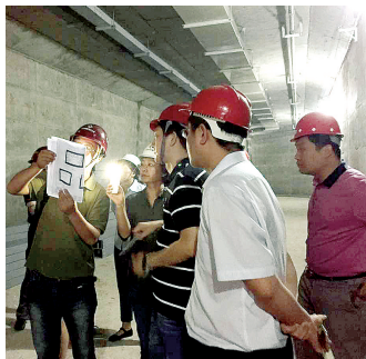
视察地铁二号线通信基础设施建设
