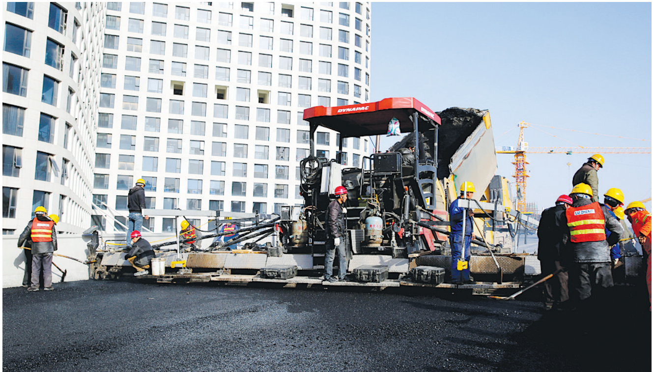
农业路高架东段沥青摊铺施工现场
