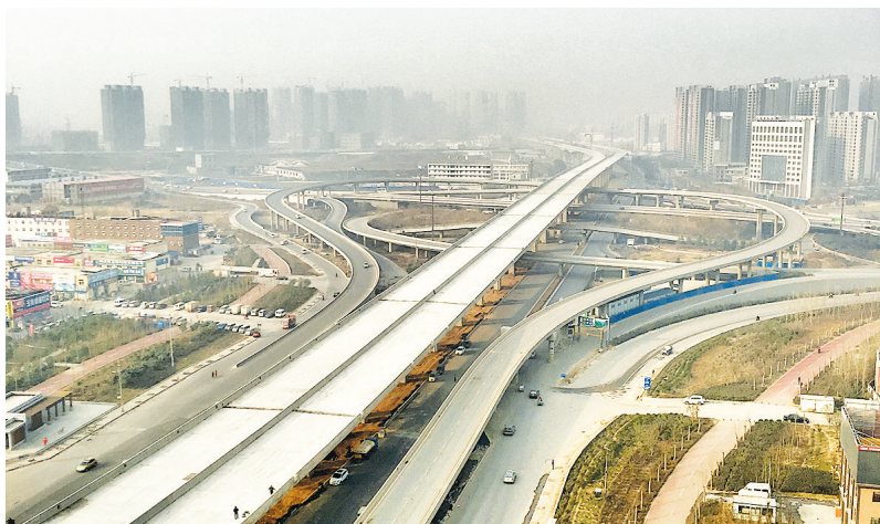
南三环东延二期工程机场高速以西段锥形桥现
