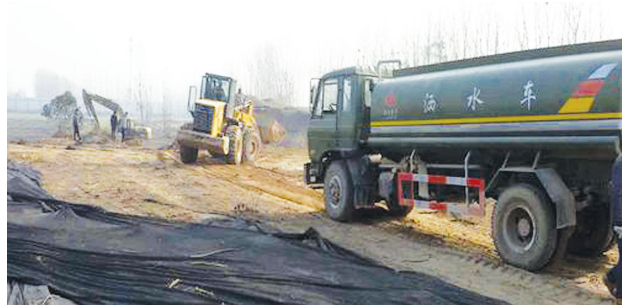
池北路建设开工
