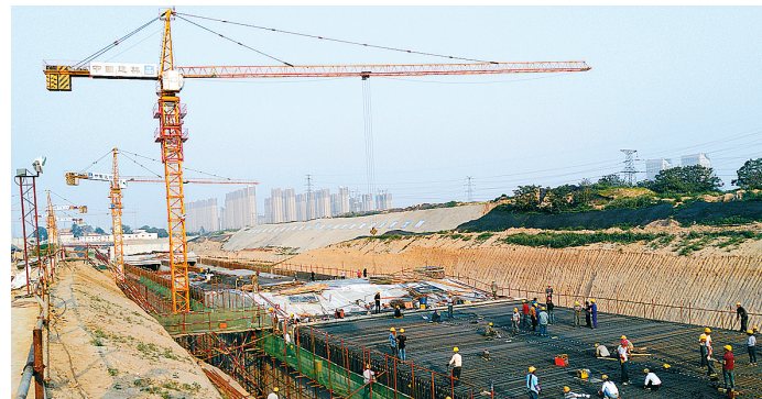
市民公共文化服务区核心区内市民大道地下隧道工程
