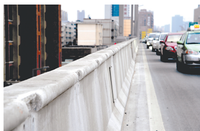
陇海高架护栏上安装声屏障的凹槽已打好
