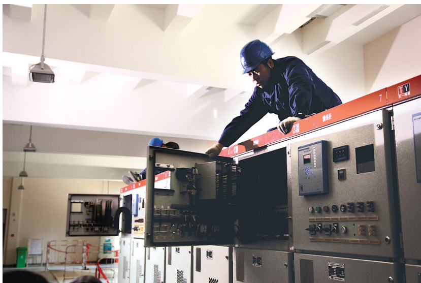
红旗变电站内部施工
