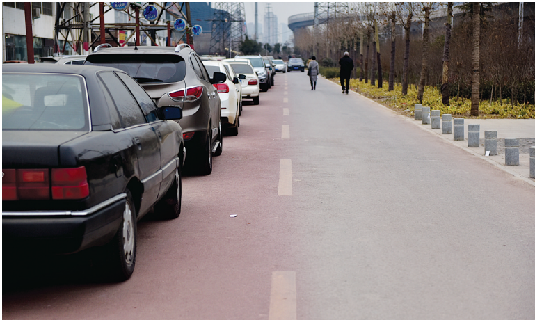
由于碾压,北三环生态廊道内自行车道颜色变灰
