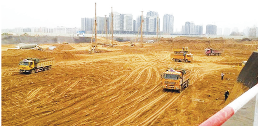
岗崔安置区项目正在紧张施工
