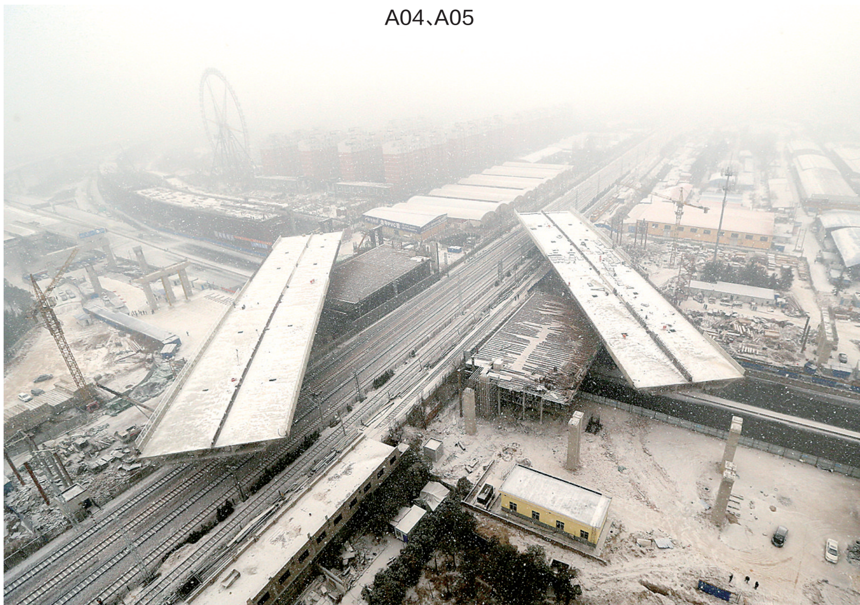
正在转体中的中州大道跨陇海铁路桥梁。郑州晚报记者 周甬 图
