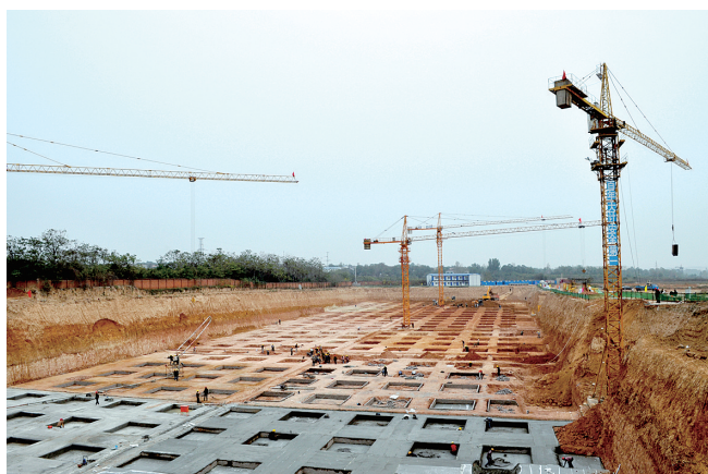
昌盛物流施工中
