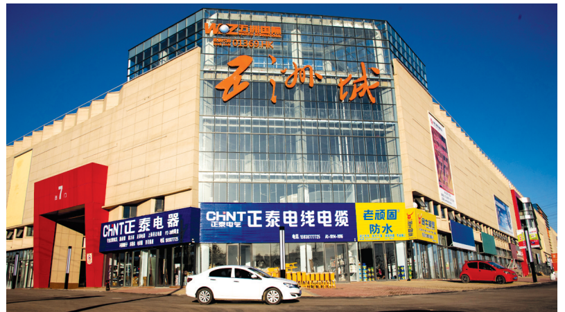
投入运营的五洲国际博览城项目一期
