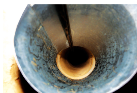
救援现场,井口做了很好的防护,防止二次伤害发生
