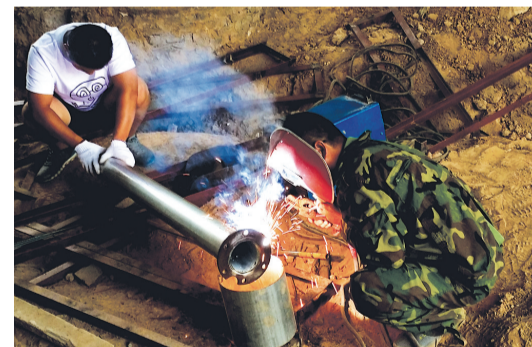
荥阳市自来水工作人员正在焊接供水管道
