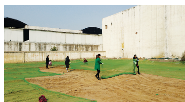
工作人员在工地拉网
