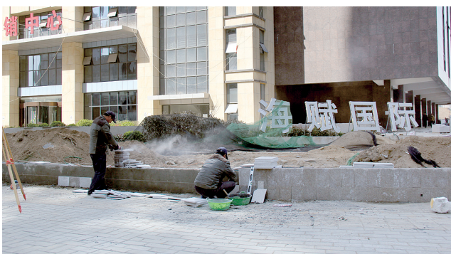
郑东新区海赋国际工地,大面积黄土裸露在外
