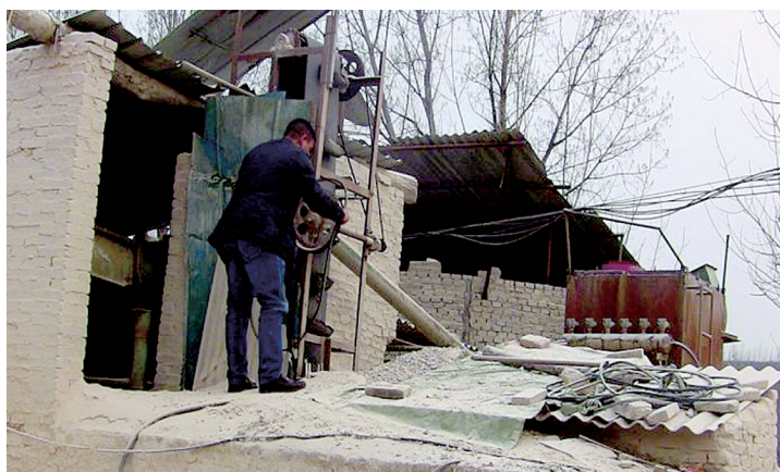
3月5日,登封市环保局执法人员对违法企业设备进行拆除
