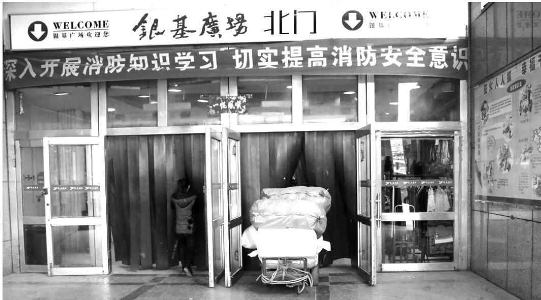
布门帘遮挡视线带来安全隐患
