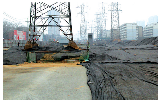
工地内裸露黄土已覆盖防尘网 郑州晚报记者 冉小平 图
