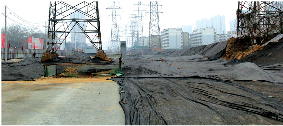
工地内裸露黄土已覆盖防尘网
