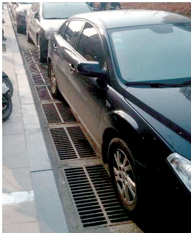
停在路边的车辆占压窨井盖
