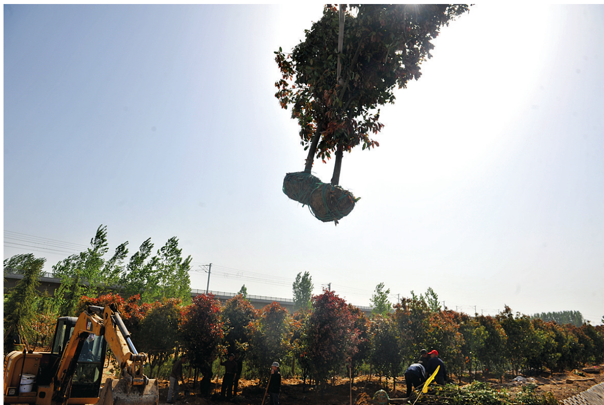
4月29日上午,郑州市委副书记、市委秘书长胡荃带领观摩组一行到经开区绿化施工现场观摩,听取了经开区党工委副书记、管委会常务副主任史占勇的汇报。据了解,在此次全市城市精细化管理20项重点工作观摩评比中,经开区的综合成绩在全市10个单位中位列前三。记者 王赛华 通讯员 张子轩
