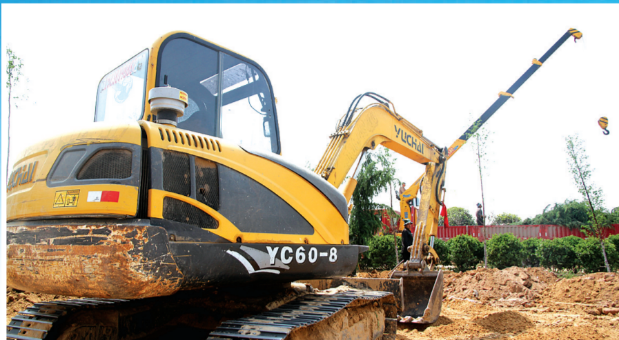
绿化施工一角 郭威 摄
