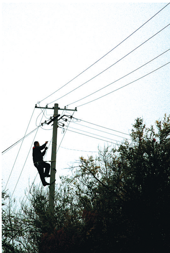
为尽早完成光改,工作人员几乎一天都在高空中作业
