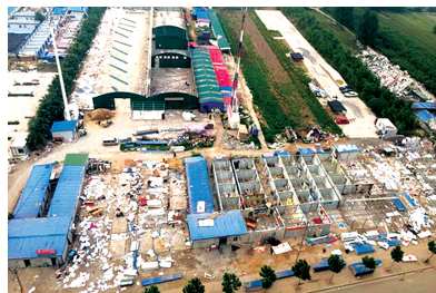
拆除私搭乱建彩板房
