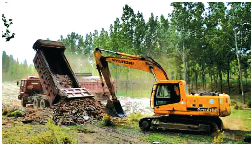
利用建筑垃圾铺设道路
