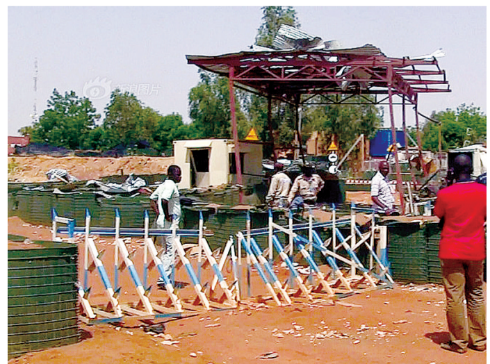
营区内部分集装箱住房在袭击中损毁
