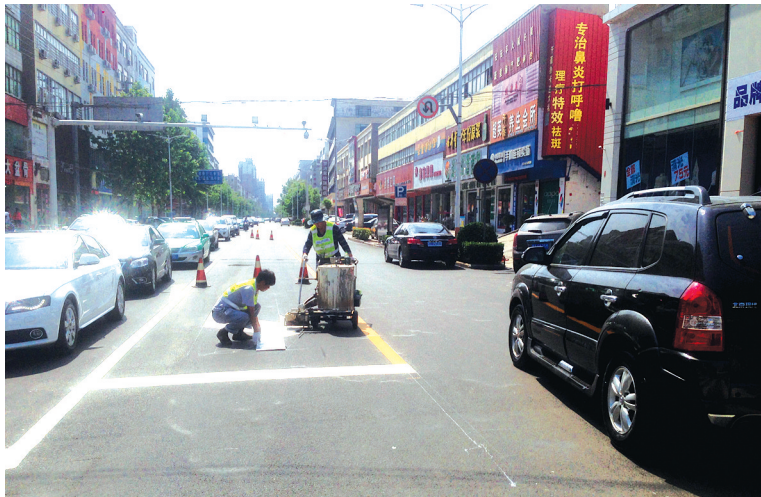
青屏街正在做道路划标线的收尾工作
