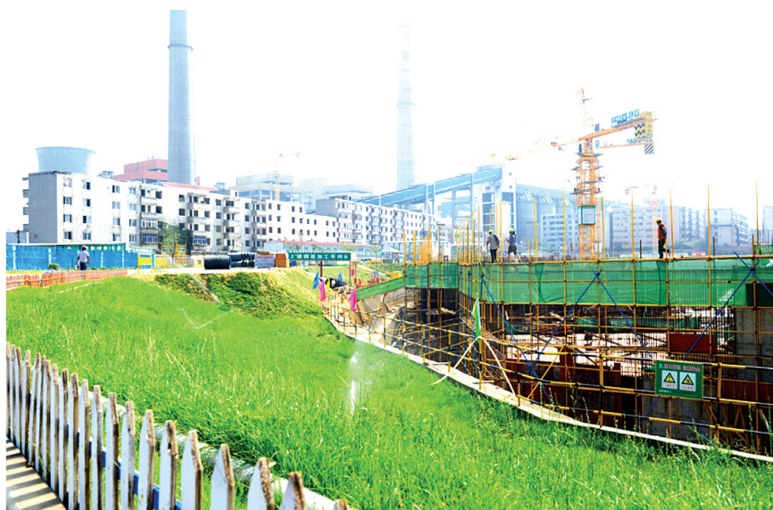
中原区一处工地种植草皮吸收扬尘
