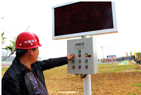
高新区一处工地安装扬尘监控设备
