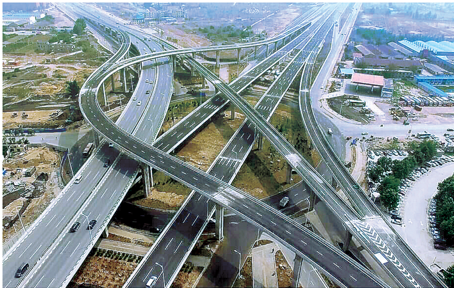
十八里河立交航拍图
