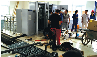
自来水厂施工现场
