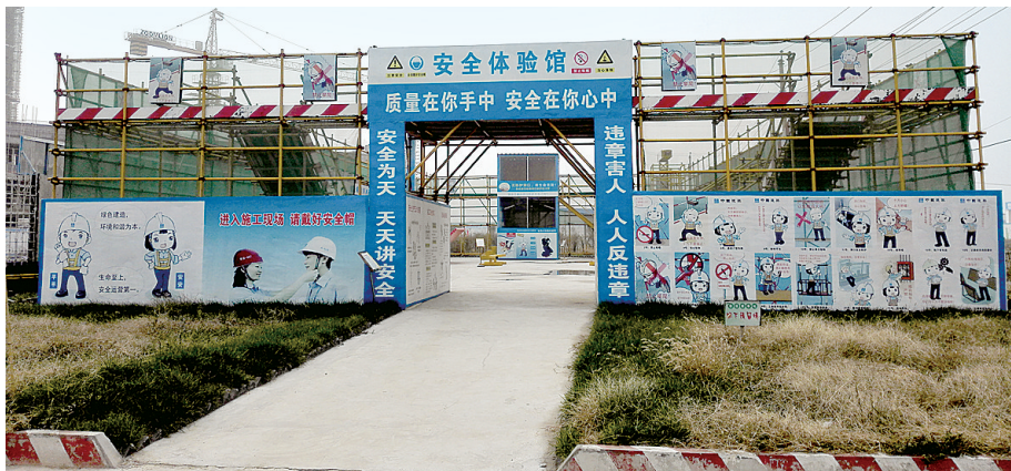
工地设立安全体验馆,让员工直观认识到工作环境中面对的危险源
