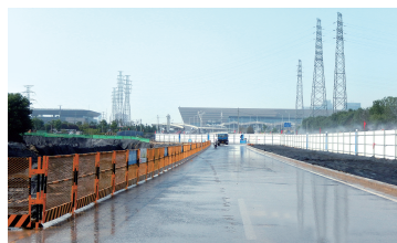
现场干净整洁,道路硬化
