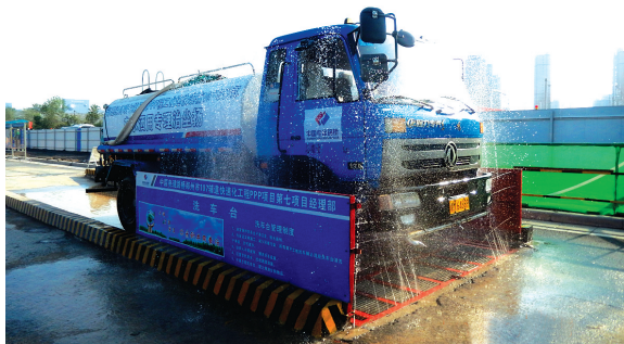
安装自动冲洗设施
