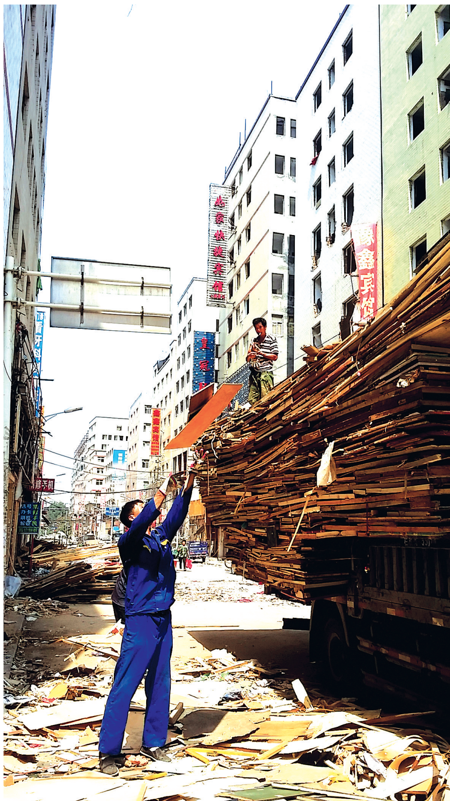
工人正在将拆卸下的木材收集起来
